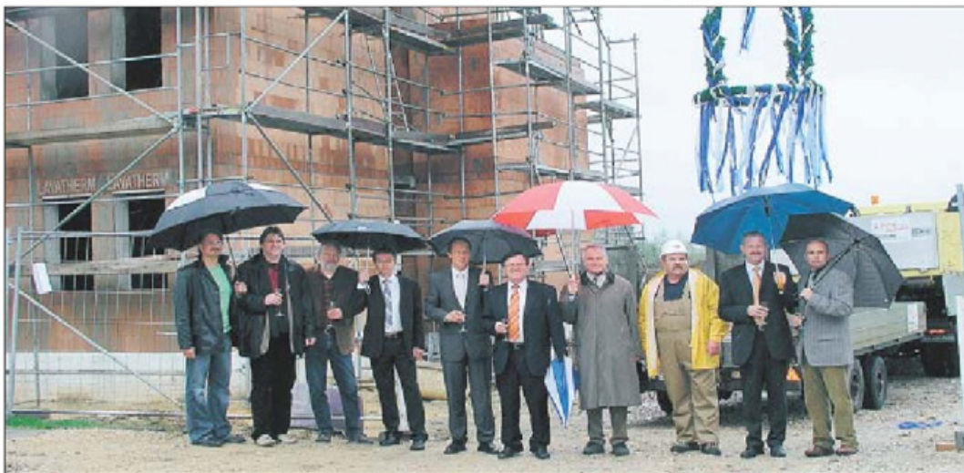
Bauherrn, Mieter, Planer, Erbauer und Bürgermeister feierten gestern Richtfest.
